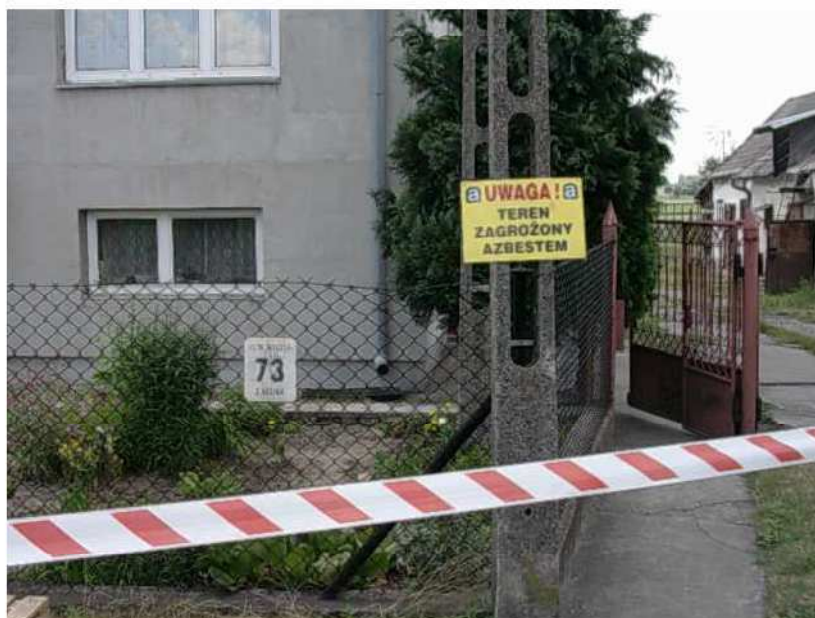
Zdjęcie 20 Prawidłowy sposób zabezpieczenia terenu zagrożonego azbestem.
