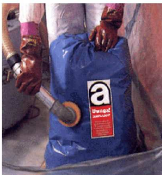
Zdjęcie 17 Przykład prawidłowego postępowania przy demontażu pokrycia dachowego z eternitu, pracownik ubrany w pyłoszczelny kombinezon z maską posługuje się specjalistycznym odkurzaczem z filtrem HEPA.
