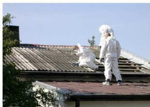
Zdjęcie 17 Przykład prawidłowego postępowania przy demontażu pokrycia dachowego z eternitu, pracownik ubrany w pyłoszczelny kombinezon z maską posługuje się specjalistycznym odkurzaczem z filtrem HEPA.
