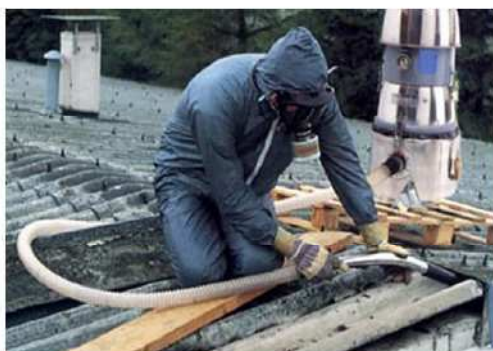
Zdjęcie 17 Przykład prawidłowego postępowania przy demontażu pokrycia dachowego z eternitu, pracownik ubrany w pyłoszczelny kombinezon z maską posługuje się specjalistycznym odkurzaczem z filtrem HEPA.
