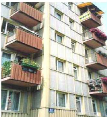
Zdjęcie 10 Elewacja wykonaną z płyt azbestowo-cementowych płaskich
