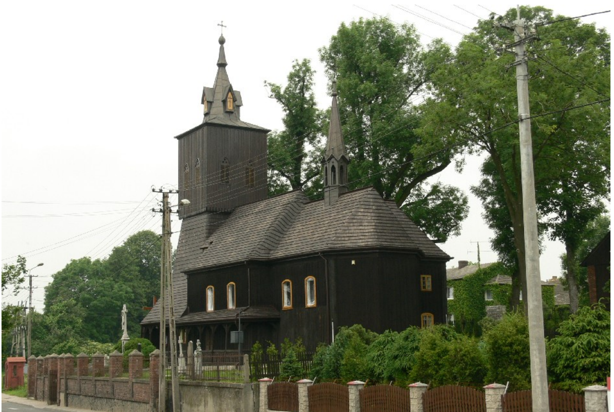
Ilustracja 45: Widok na kościół, widoczny fragment szpaleru dębów szypułkowych
