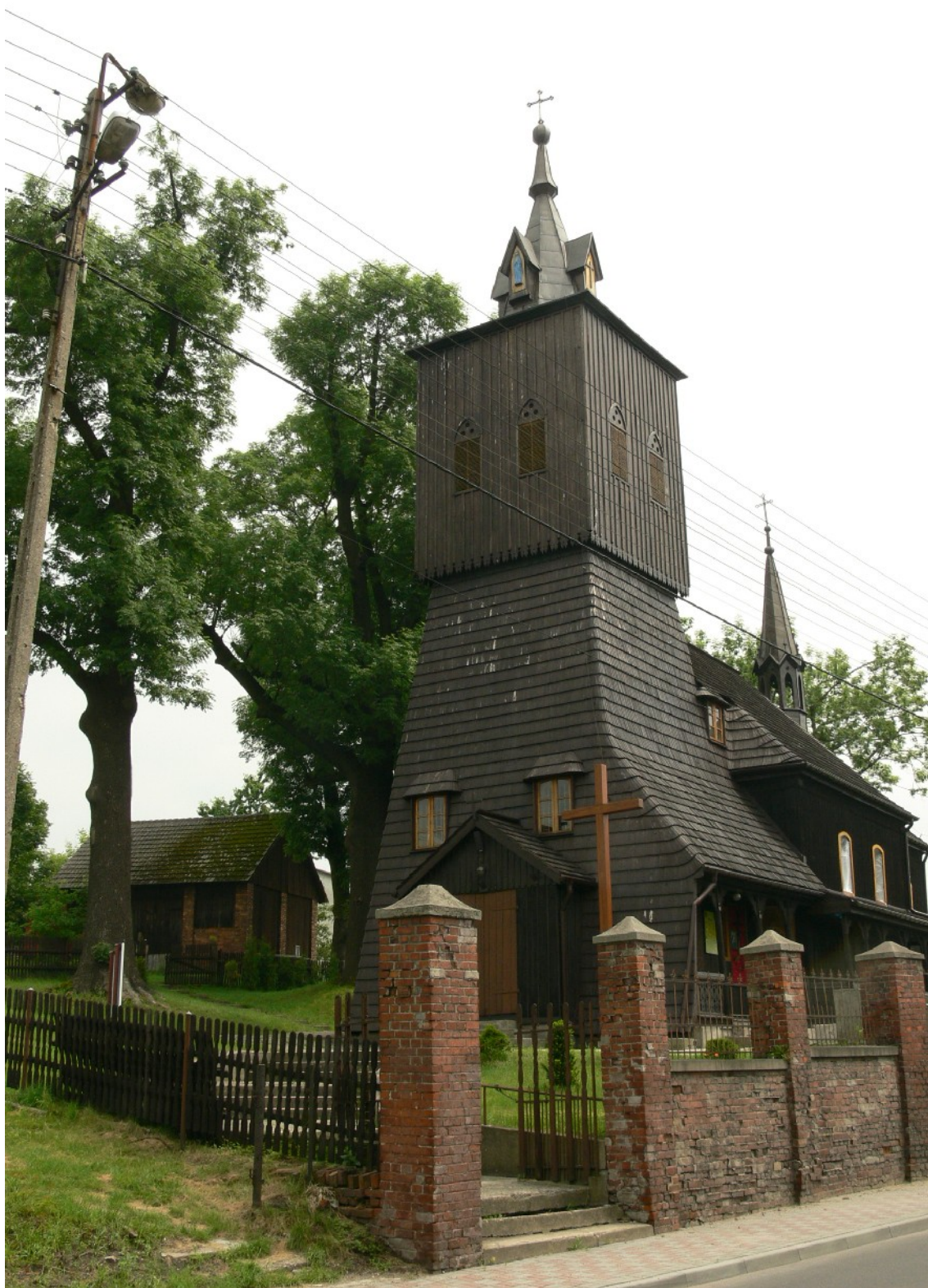
Ilustracja 44: Widok na kościół, widoczny fragment szpaleru dębów szypułkowych
