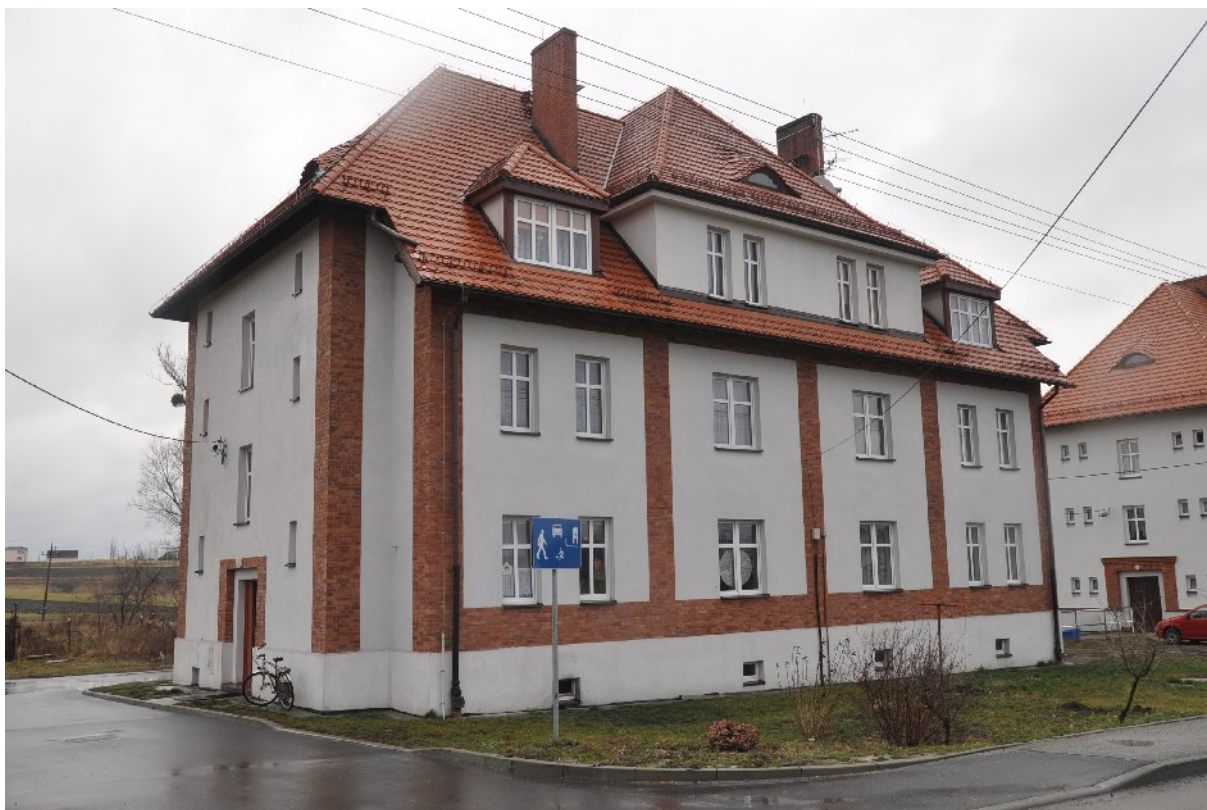
Ilustracja 19: Kolonia Fryderyk, ul. Leśna 1 - budynek wchodzący w skład kolonii robotniczej przy kopalni.
