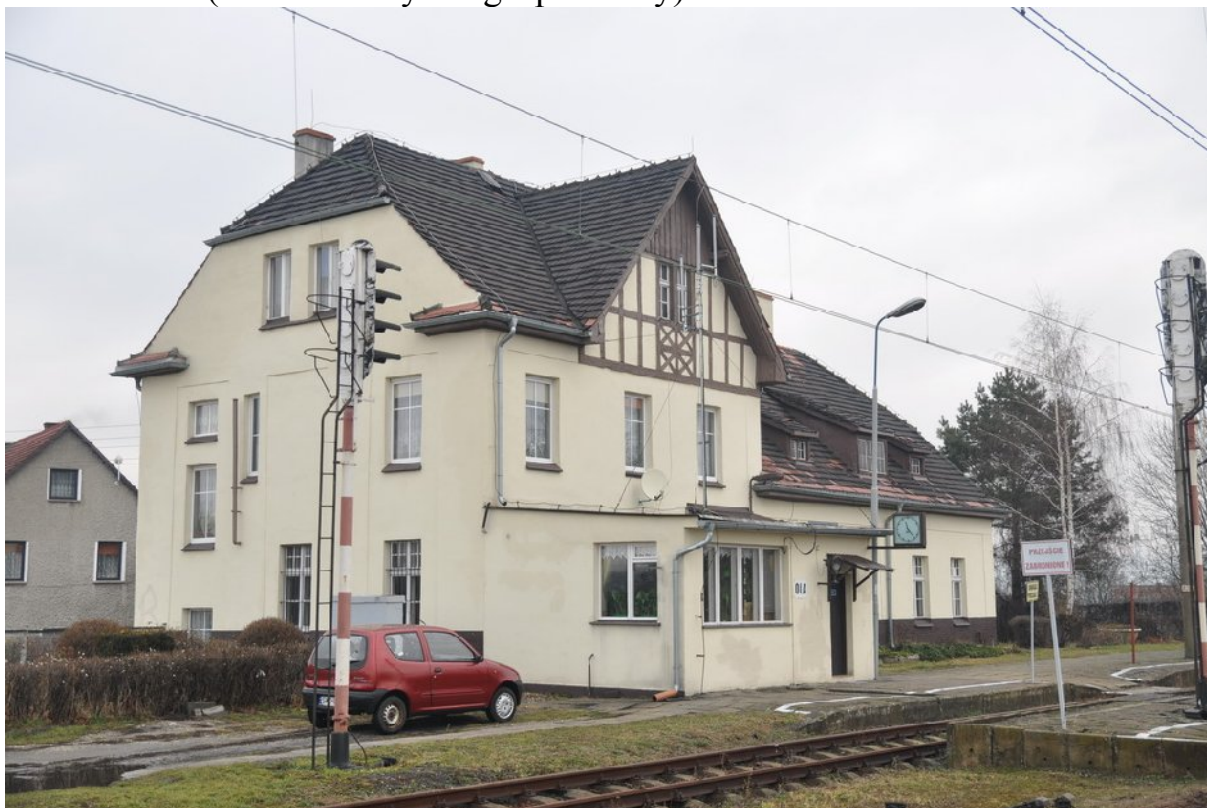
Ilustracja 23: Olza, dworzec kolejowy.
