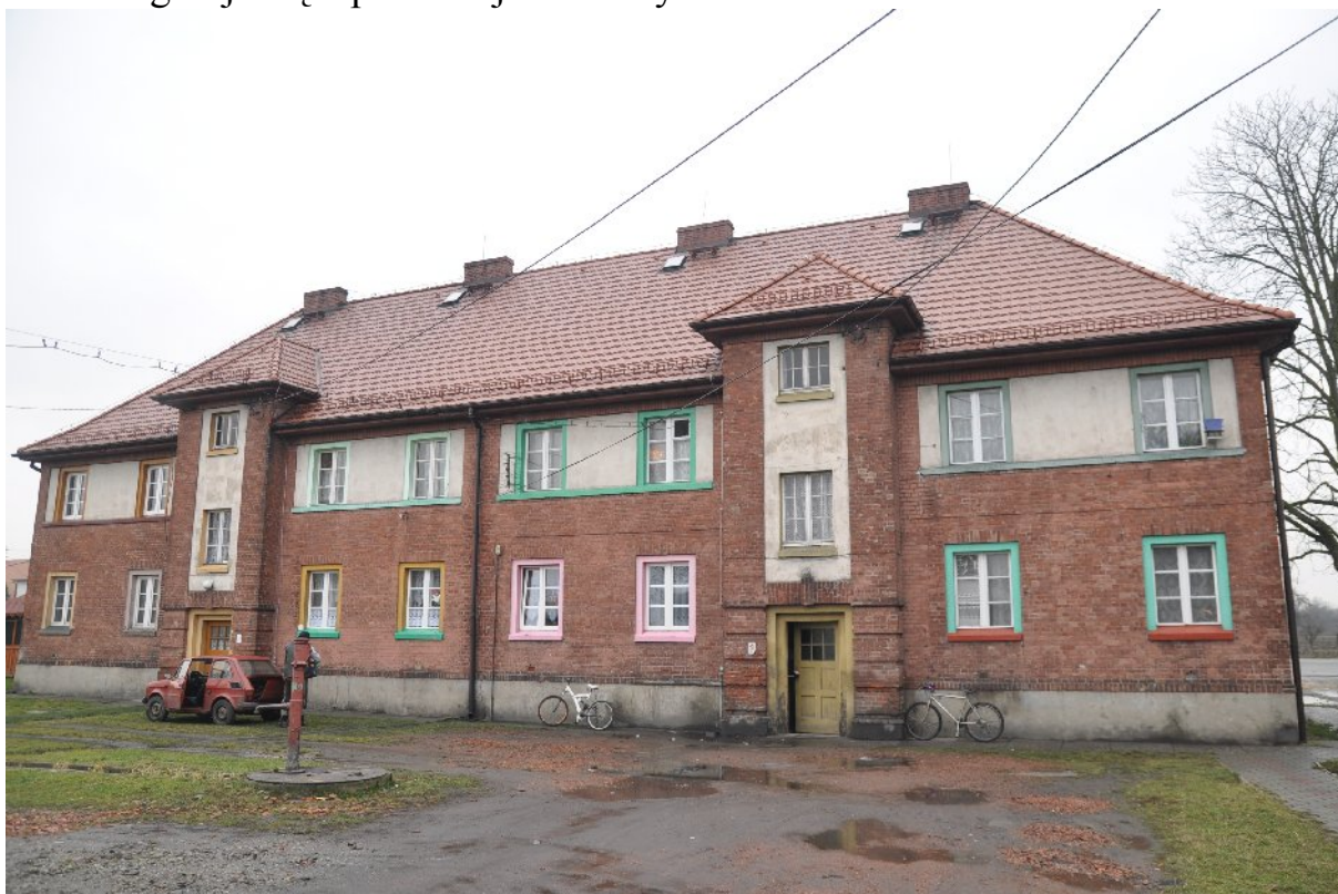
Ilustracja 33: Olza, ul. Dworcowa 90 - budynek Oleckiej kolonii robotniczej.
