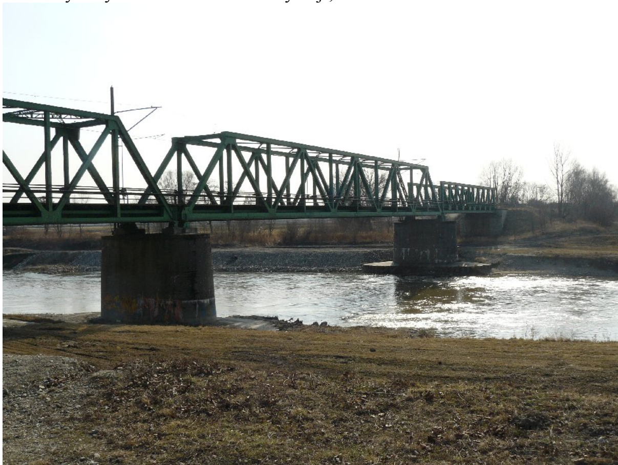
Ilustracja 1: Olza - stalowy most kolejowy na rzece Odrze.
