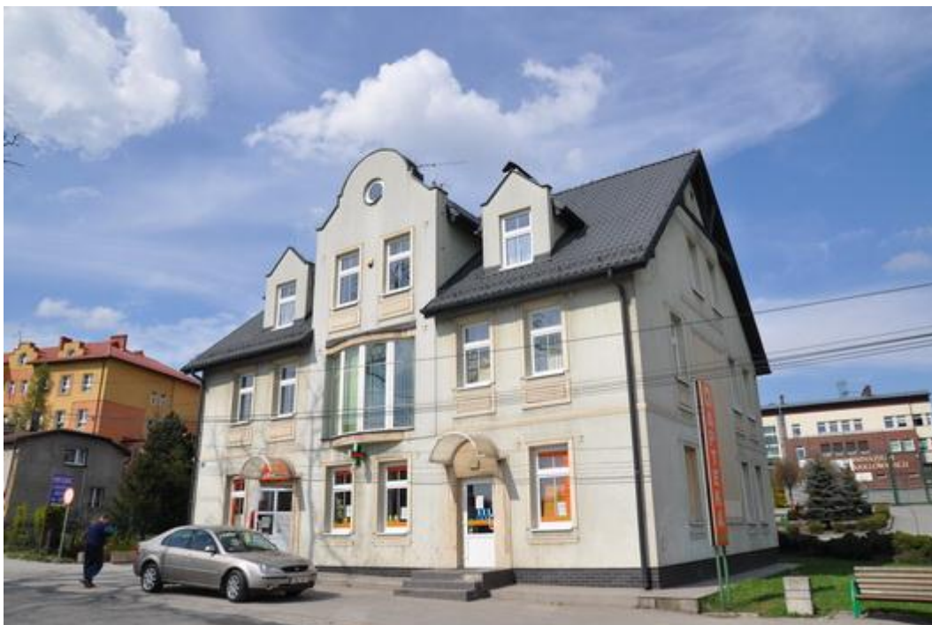
Ilustracja 8: Odrestaurowany budynek przy ul. Wyzwolenia 156.
