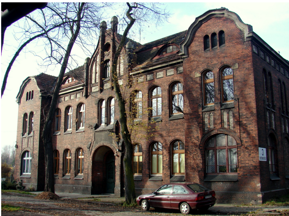
Dawny budynek administracji kopalni "Laurahuta" (rejon Ficusus)
