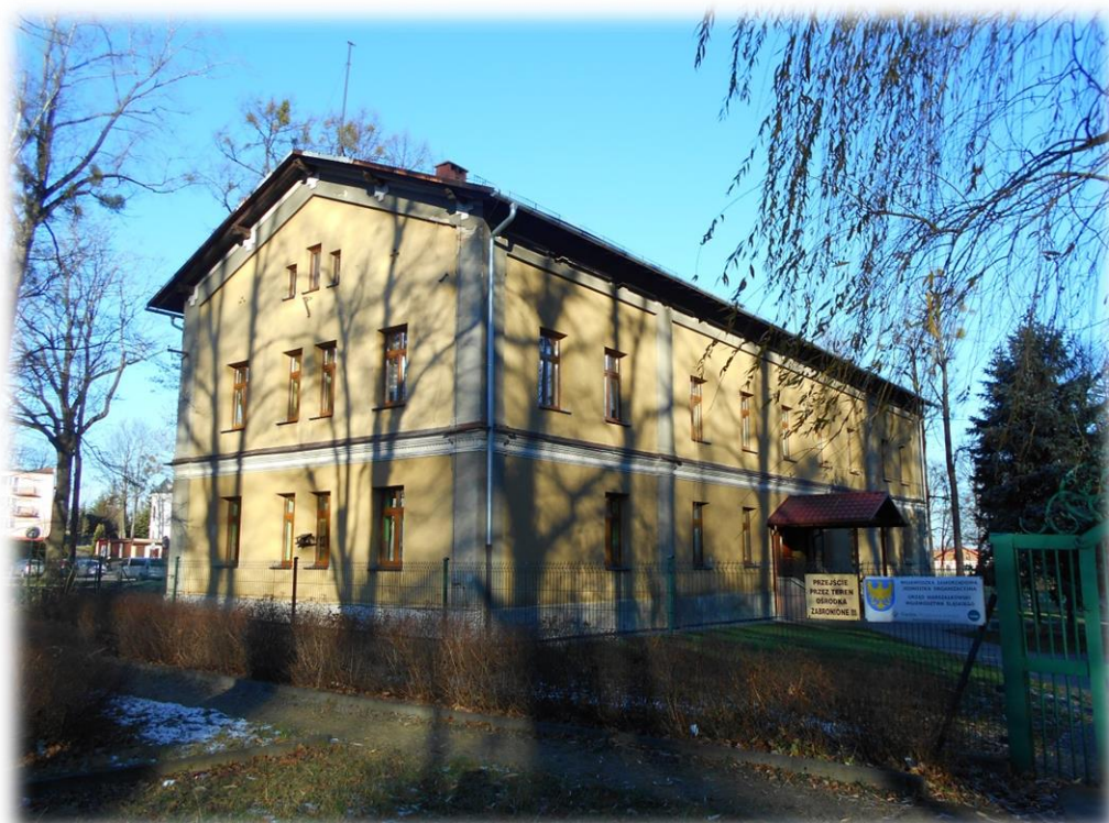
ul. Pałacowa 90 – dawny dom zdrojowy Kurhaus (obecnie internat MOW)
