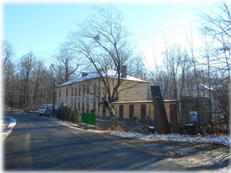
ul. Pałacowa 92 – budynek bramny
