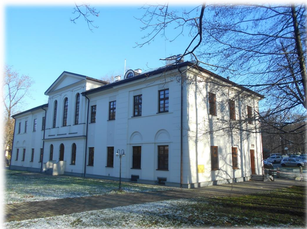
ul. Pałacowa 1 – budynek pałacu barona Arnolda Saint-Genois d'Anneaucourt
