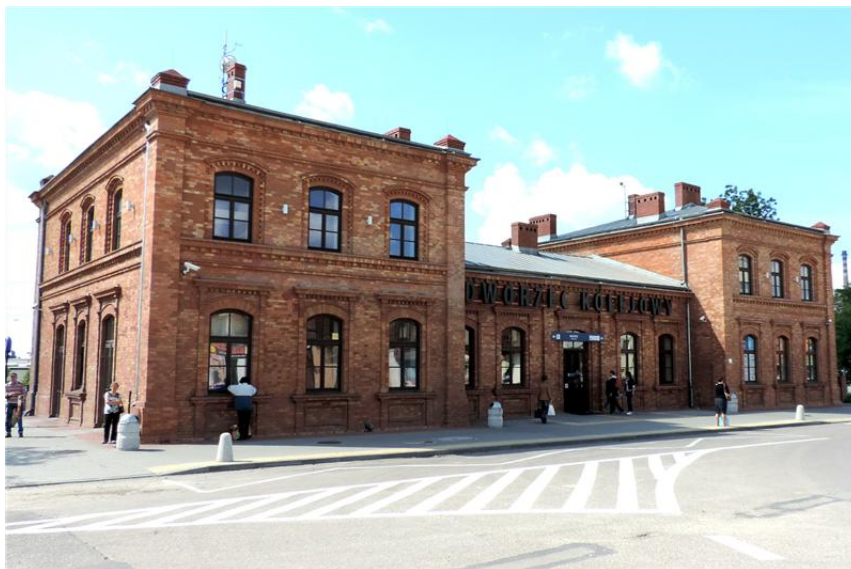
Zdjęcie nr 5. Dworzec kolejowy.
